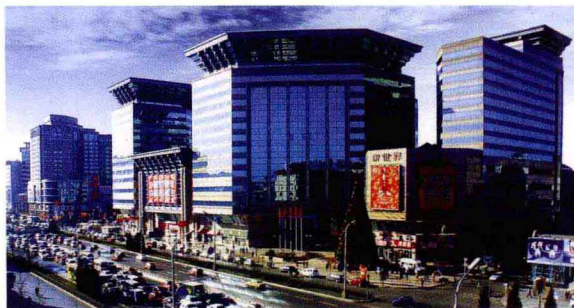
新世界商场1994年破土动工，1998年6月商场及酒店投入使用。2001年，该商场以其独特的建筑风格入选九十年代北京十大建筑。图为新世界商场大楼外景
