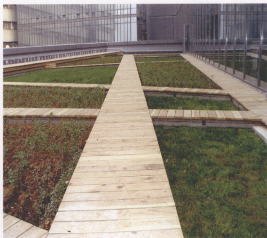
屋顶绿化技术，设置屋顶花园，生态节能。屋面电动遮阳百叶安装整齐，开启灵活。
