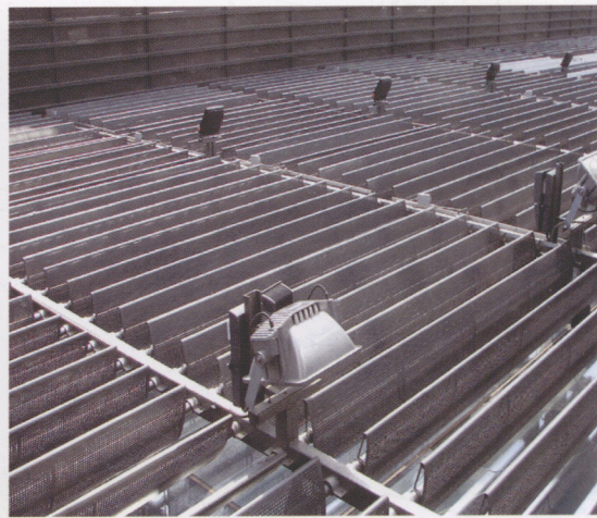
屋顶绿化技术，设置屋顶花园，生态节能。屋面电动遮阳百叶安装整齐，开启灵活。
