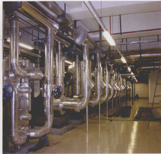
暖通空调采用低温送风与冰蓄冷节能技术，结合楼宇监控系统，高效、节能。
