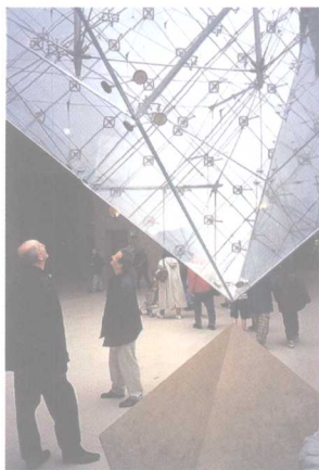
图0-23 巴黎卢浮宫的倒金字塔,一个不可思议的以钢为主的结构体,尽管它的本意是创造一个玻璃金字塔
