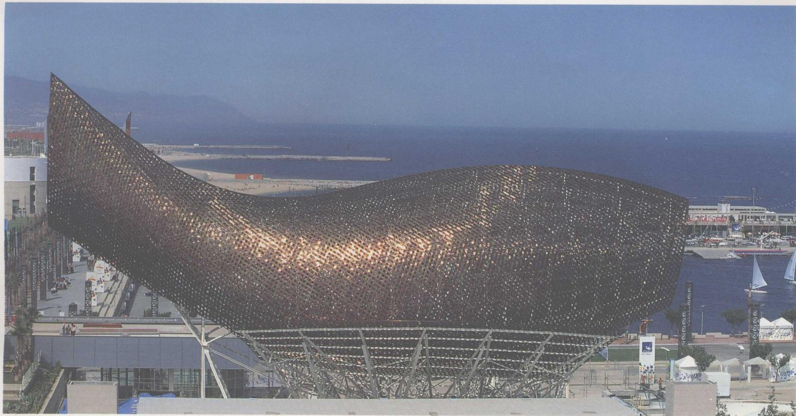
*Il volume del Pesce è ottenuto con una campitura di fasce in acciaio colorato, intrecciate e distese su di una struttura metallica reticolare. Pagina a sinistra sezione costruttiva e grafico computerizzato delle ordinate di sezione.*
