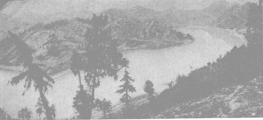
石堰人民公社新建成的三条沟水庫，蓄水六百多万立方米，能灌田三万多亩。
