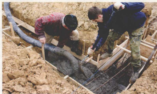
混凝土浇筑
