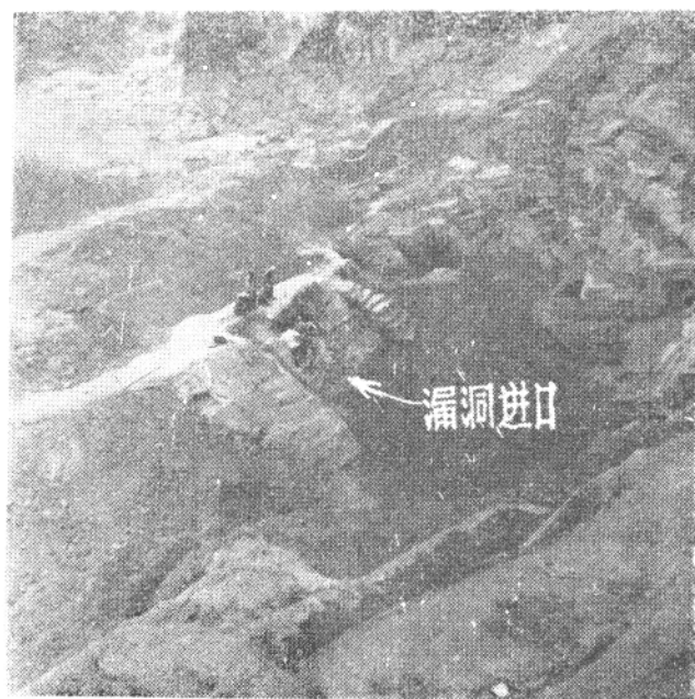
上林县大龙洞水库坝首漏水洞进口
