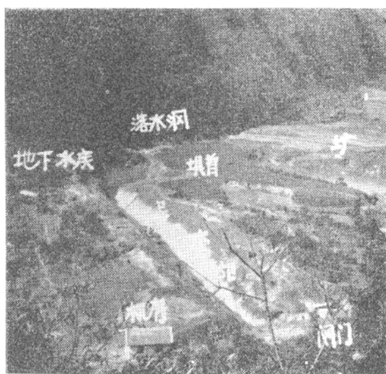
隆林县蛇场公社卡拱谷地地下河出口段
