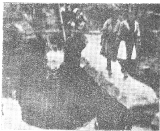
隆林县蛇场公社雷天水筑堤围泉
