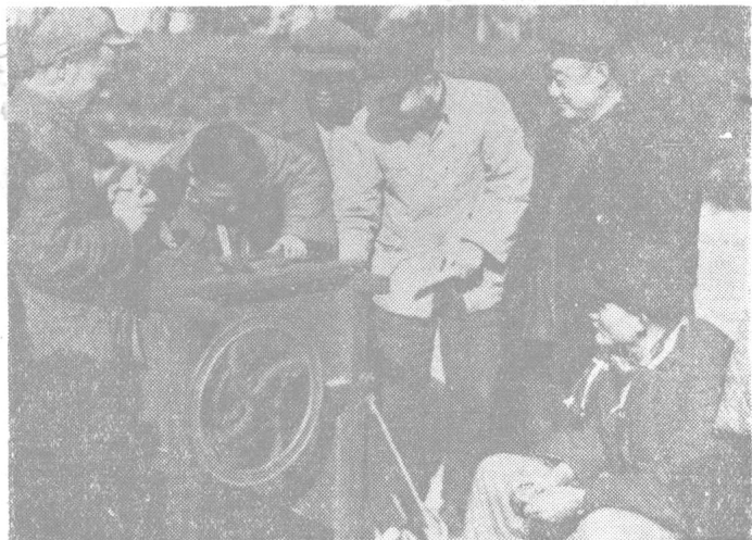
結合學習使用技術，並練習裝修技術，圖示該班學員在實習裝拆「玉米脫粒機」的步驟。
