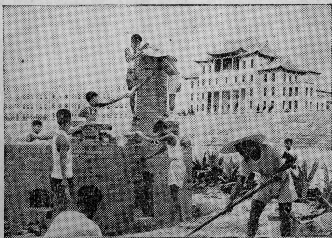
同學們在建耐火磚爐
