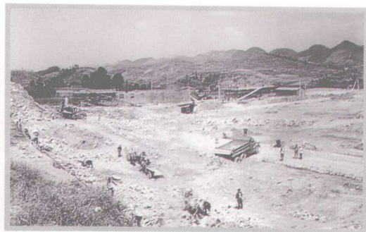
1983 年遵义市水泥厂建设工地一角。
