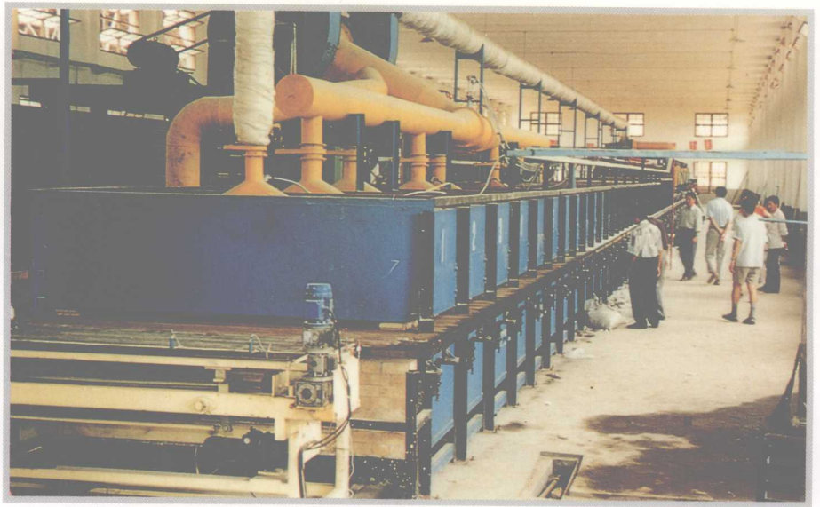
遵义东安建筑陶 瓷责任有限公司墙地 砖生产车间。
