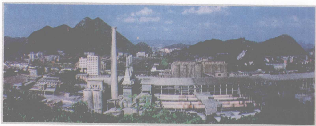
贵州水泥厂全景。
