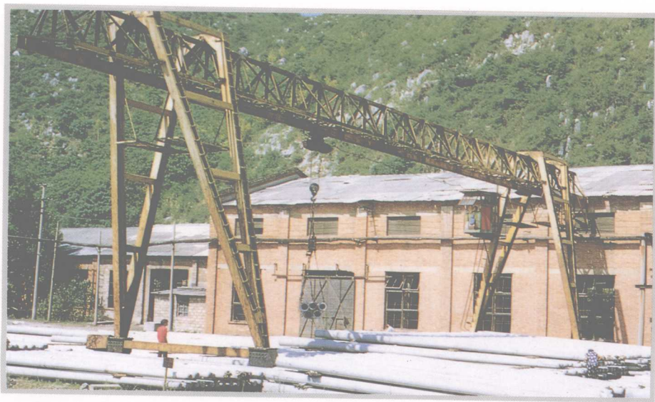
贵州省花溪电杆厂成品场。
