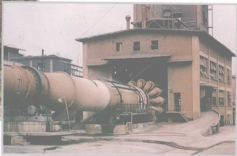
贵阳市水泥厂回转窑车间一角。
