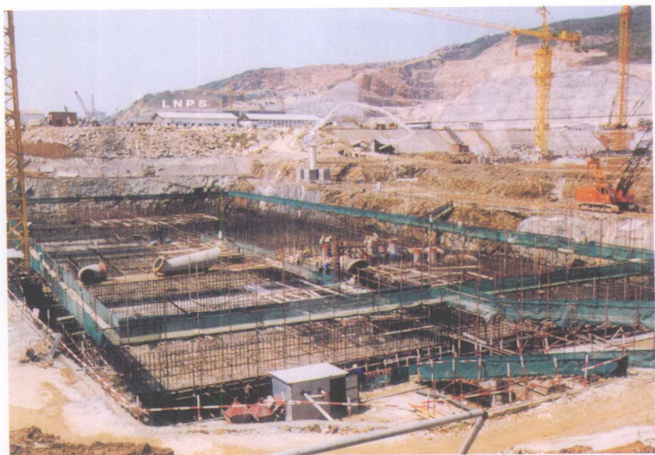
广钢钢材被指定为大亚湾岭澳核电站核岛工程的建筑用钢材
