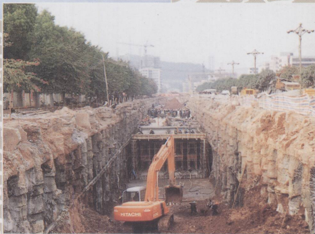
广州地铁一号线建设工地
