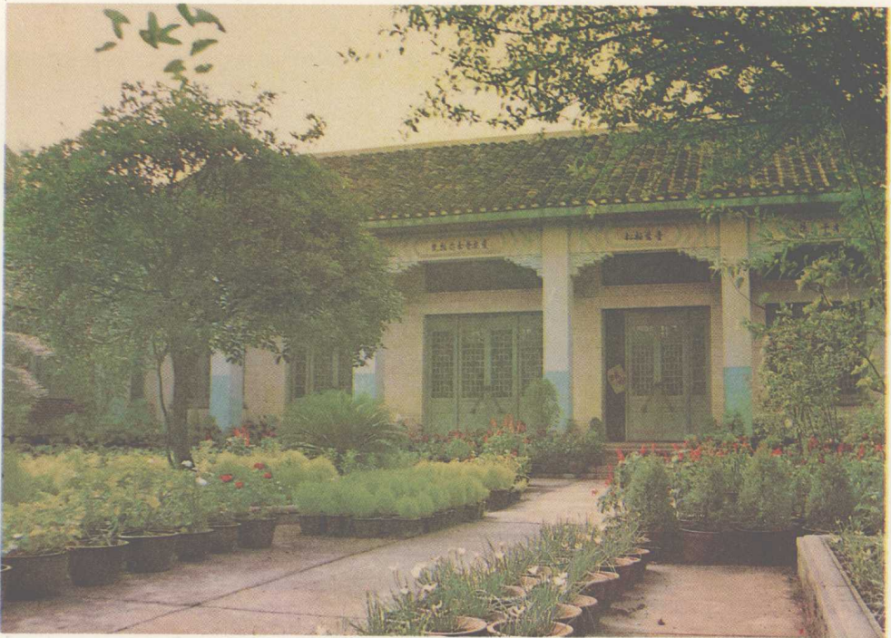
贵阳市殡仪馆骨灰堂
