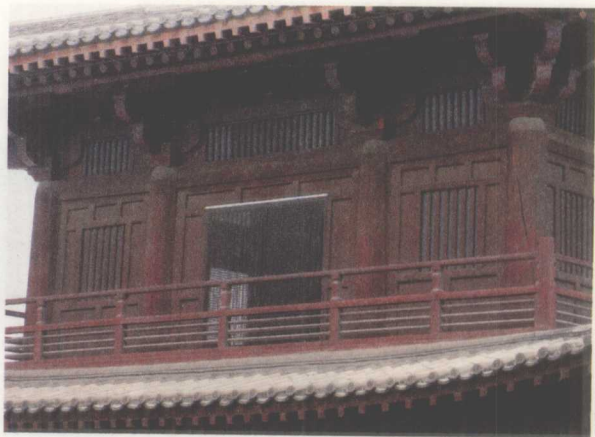
河北正定开元寺唐代钟楼直棂窗，是唐代最通行的窗户式样
