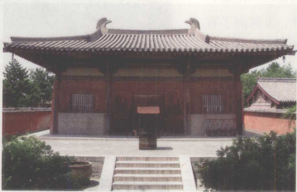
山西五台唐代南禅寺大佛殿是保存完好的唐代建筑
