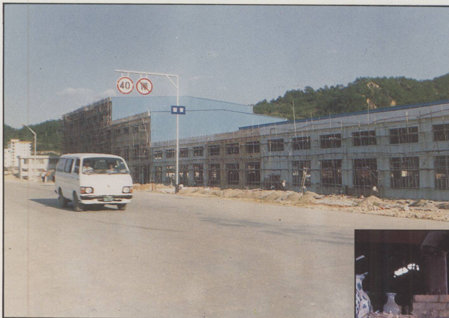
建設中的大埔建築陶瓷廠
