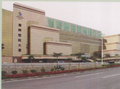
佛山鹰牌陶瓷公司 Eagle Brand Holdings-Headquarters
