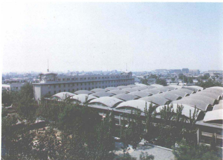
六十年代初新型薄壳厂房(由第五设计研究院设计的218厂机加厂房)
