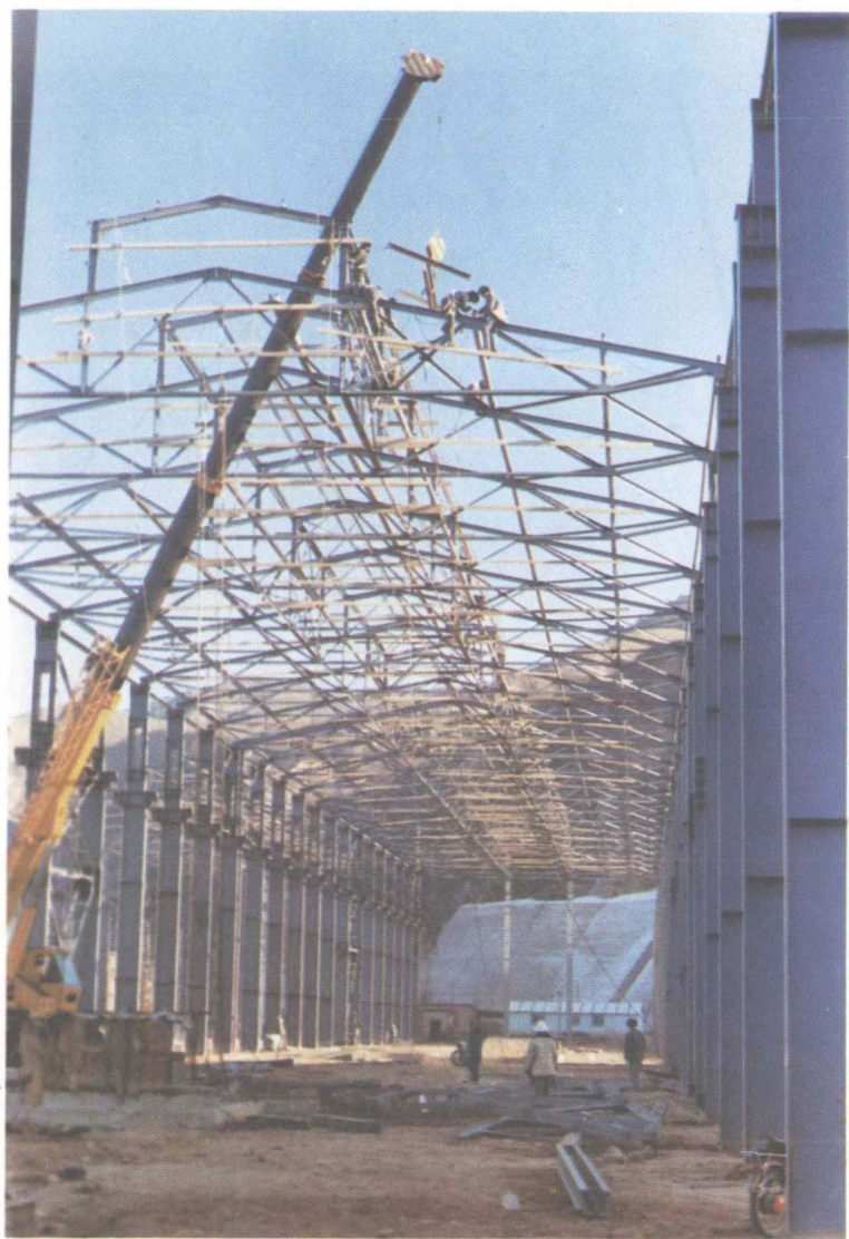
5409 厂钢结构厂房
