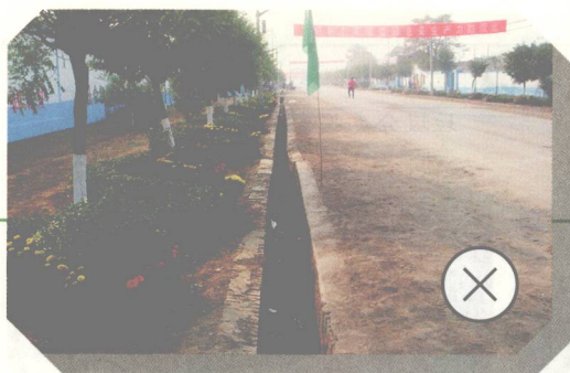
建设雨水排放系统
