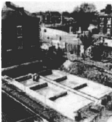
图 1.5 英国一学校建筑的平移
