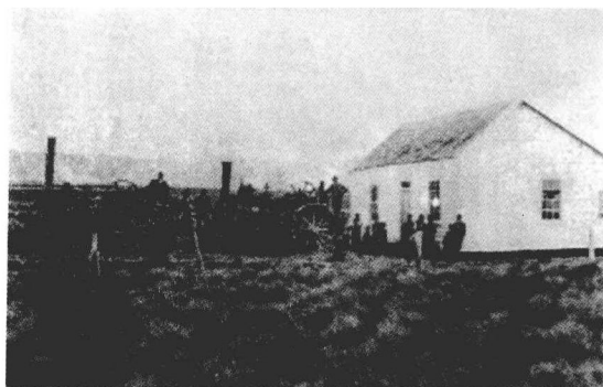
图 1.1 蒸汽机车牵引农宅平移
