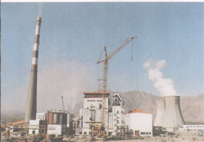
建设中的桥头 发电厂五期工程 (2X12.5 万千瓦)
