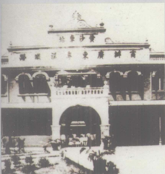
1901年建成的商办广东粤汉铁路黄沙车站。
