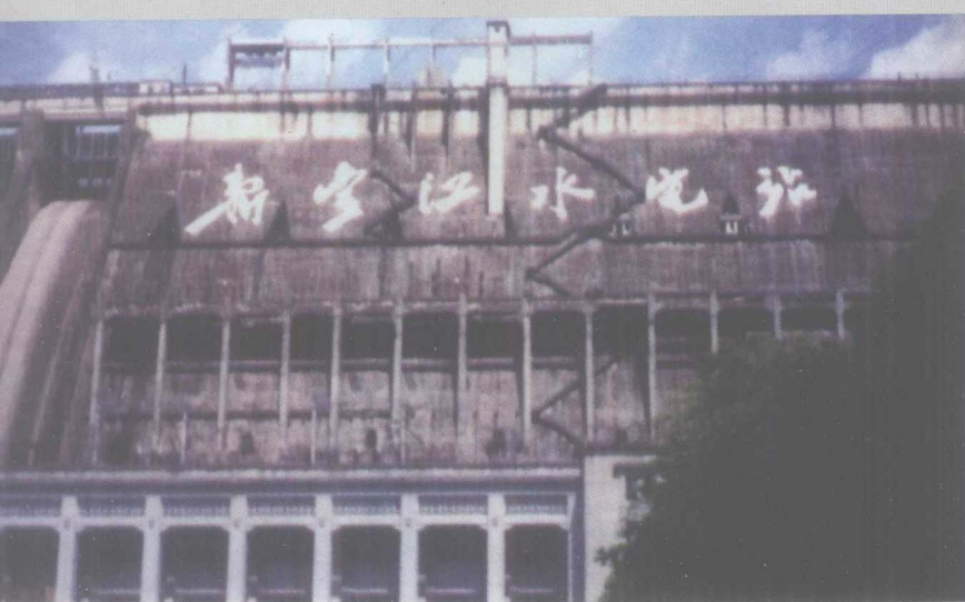
1960年建成的新丰江水电站。
