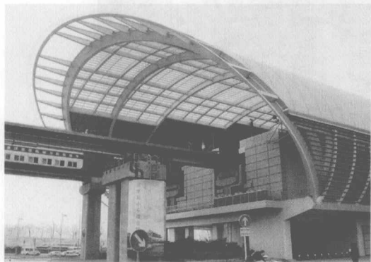
● 图 1-1 建筑物——上海龙阳路磁悬浮站站房
