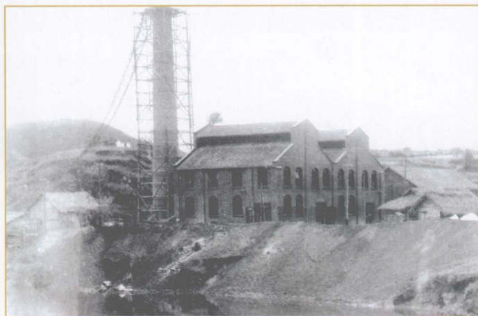
1938年始建的水口寺贵阳电厂厂房
