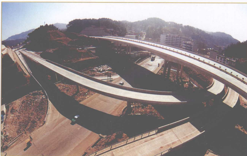
贵阳环城公路东出口新添立交桥
