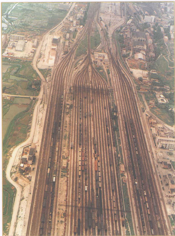
贵阳南站铁路枢纽鸟瞰
