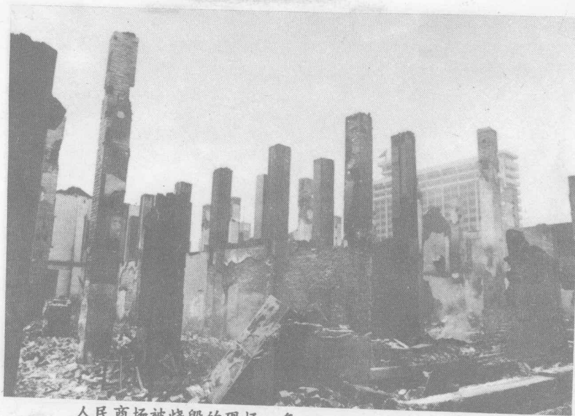
人民商场被烧毁的现场一角。
