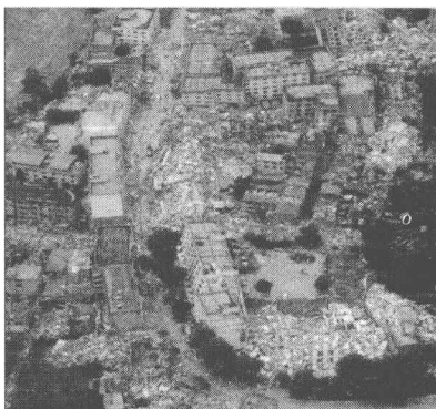
图 1.9 汶川地震的建筑物倒塌破坏
