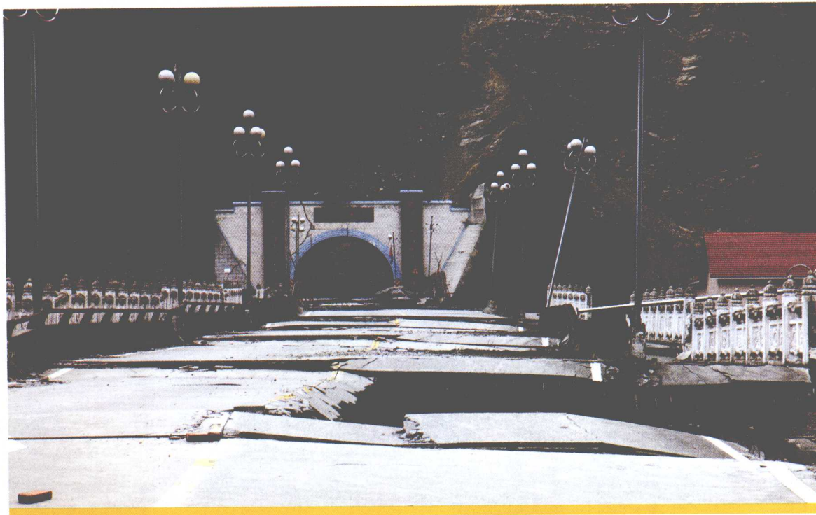
北川通往小寨子沟的大桥在地震中被毁。
