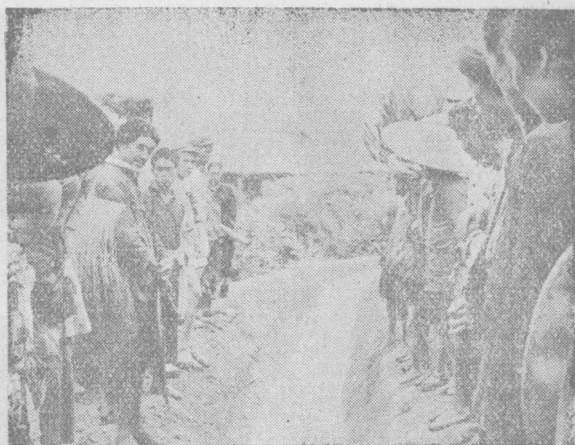
抽水機抽上來的水，沿着渠道流到田裏。
