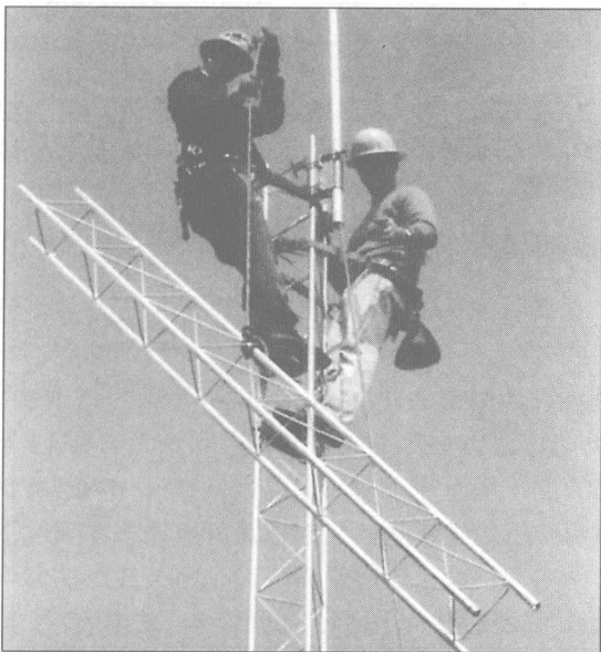
图1-5 当使用起重吊杆将每一个组件吊装至合适的位置时，天线塔零件的组装就变得非常简单了。注意到两个攀塔者的安全带都在电杆的下面扣牢，因此可以防止皮带从顶端的部件上滑落。（图片由K1WA提供）
