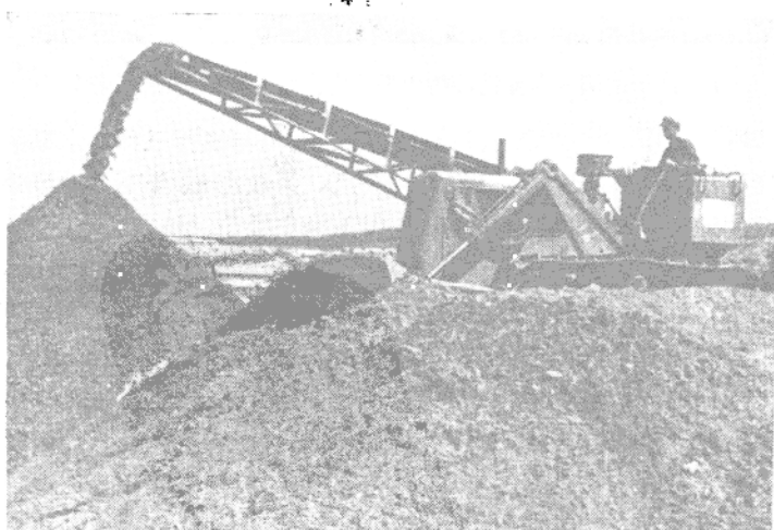
搖臂式皮帶卸砂及推土機散砂的情形
