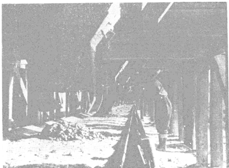
倒卸砂料的漏斗与輸送砂料水平式皮帶輸送机相連接的情形
