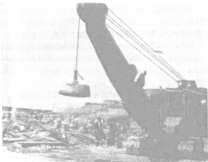
打夯机在夯实攔河土壩砂料
