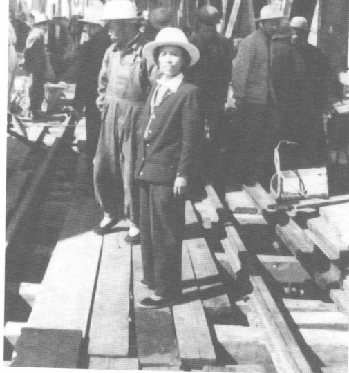
1956年6月在武汉长江大桥工地采访。
