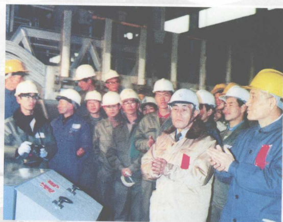
1981年12月18日，贵州铝厂引进的8万吨电解铝工程首批电解槽建成投产。
