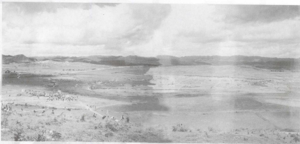
1958年贵州铝业公司建设工地全景
