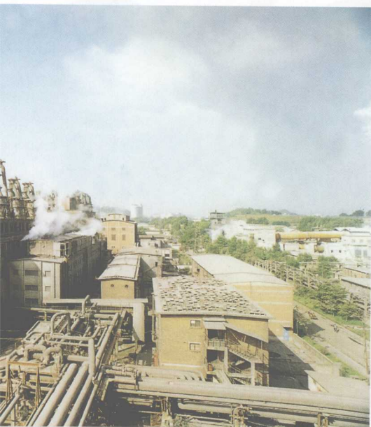
贵州铝厂为氧化铝厂和电解铝厂 生产提供高压蒸汽的热电厂
