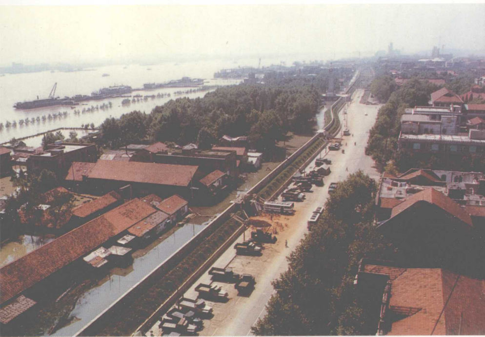
下图：今日武汉市堤防水墙
