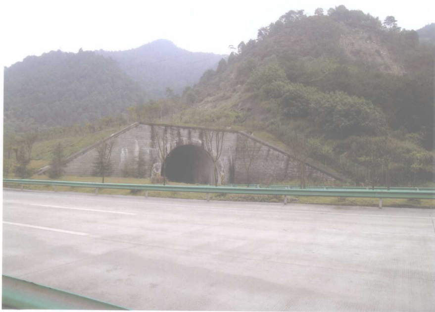
图1.12 重庆渝黔高速公路采用半隧半路绕避边坡病害。(邓卫东 摄)
