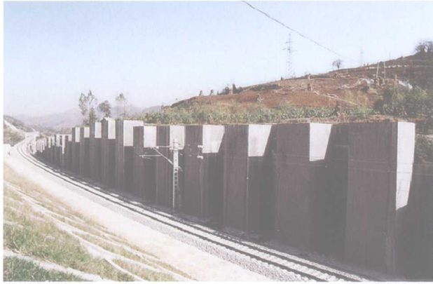
图1.5 西安至南京铁路岭底滑坡为一处于不稳定状态的巨型老滑坡。采取桩板复合结构整治，抗滑桩截面 3.5\text{m} \times 3.5\text{m} ，桩长 21 \sim 30\text{m} ，桩间设置挡土板。
