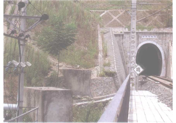
图1.6 渝(重庆)怀(化)铁路武隆纸厂滑坡为一巨型堆积层滑坡。铁路采用隧道穿越滑坡中部。采用抗滑桩、抗冲刷挡土墙及河岸防护工程综合整治滑坡。
