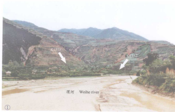
图 1.1 陇海铁路宝鸡至天水段被誉为中国铁路的“盲肠”。1963 年发生 K1358 滑坡(左), 1981 年发生的 K1357 高速远程滑坡(右)使渭河断流。为彻底避开滑坡危害, 不得不两跨渭河改移线路。
