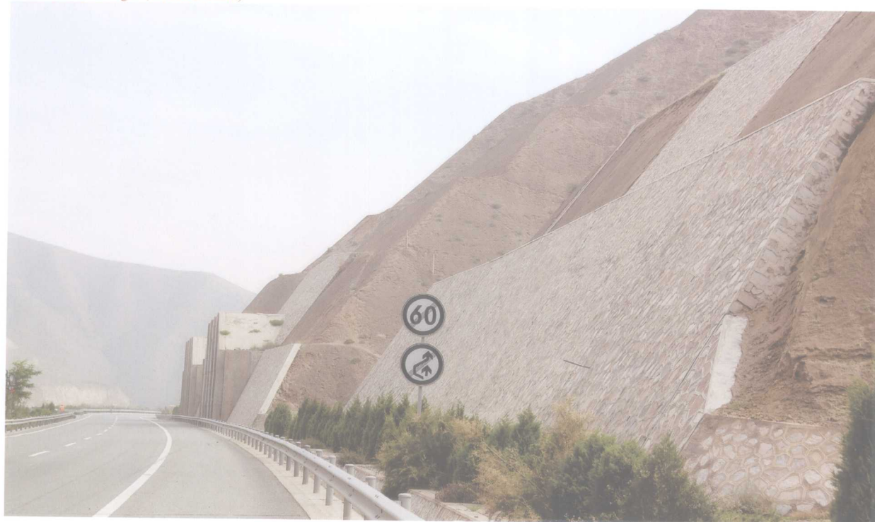
图 1.9 高大、突显的路侧桩、墙支挡结构显得厚重、压抑。(朱聪功 摄)
