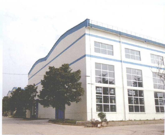
冷拔车间外貌
