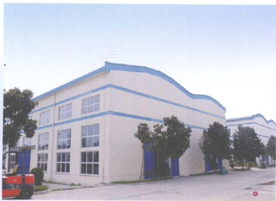
金三车间外貌
