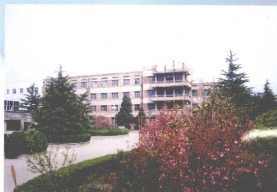
20 世纪 90 年代初第一机电修配厂办公楼远景
