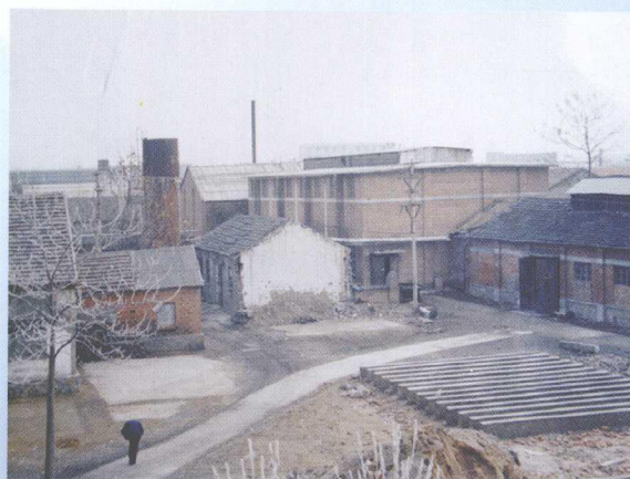
20 世纪 60 年代机电修配厂（渠沟）厂区一角
