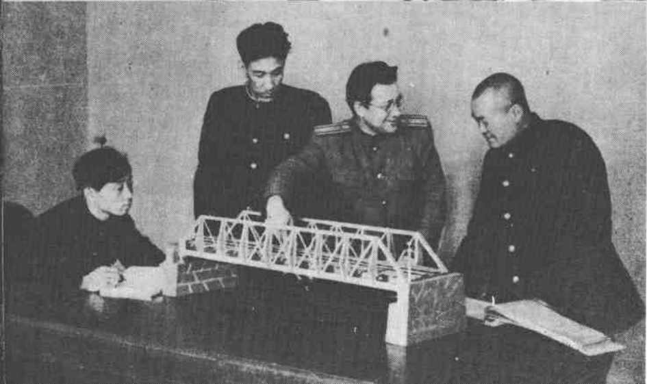
在蘇軍幫助下，大連鐵路 工人與蘇軍共同修復了金城綫 這是蘇軍技術人員與鐵路 工程技術人員在研究架設橋梁
