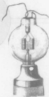
图 1.1.1 世界上第一只电子管 (真空二极管)
