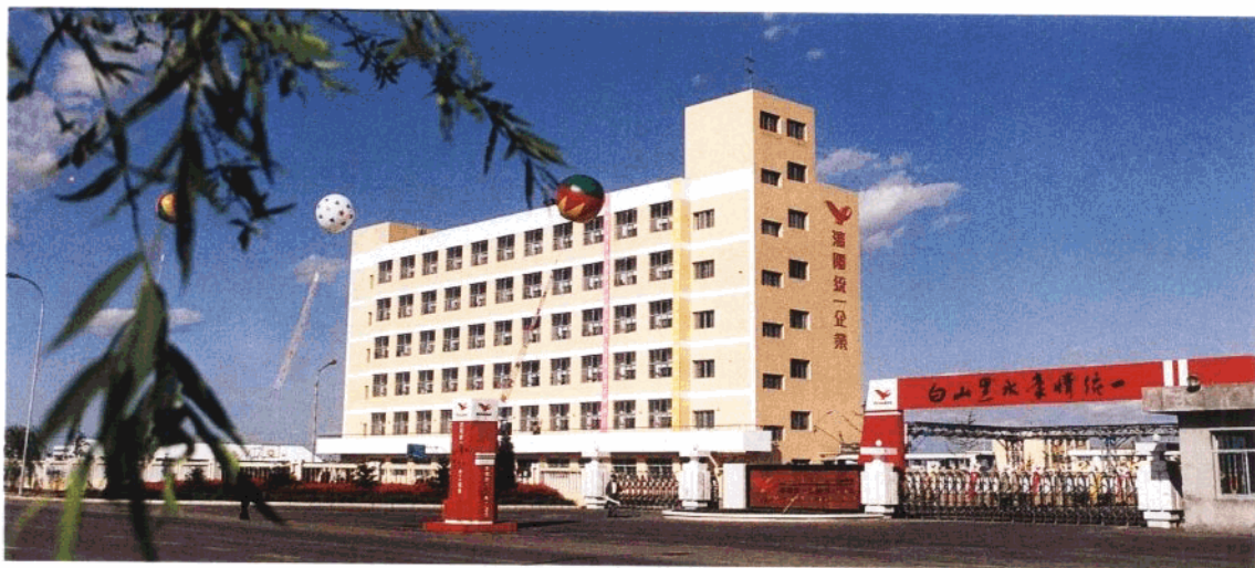
沈阳统一公司大门外貌
