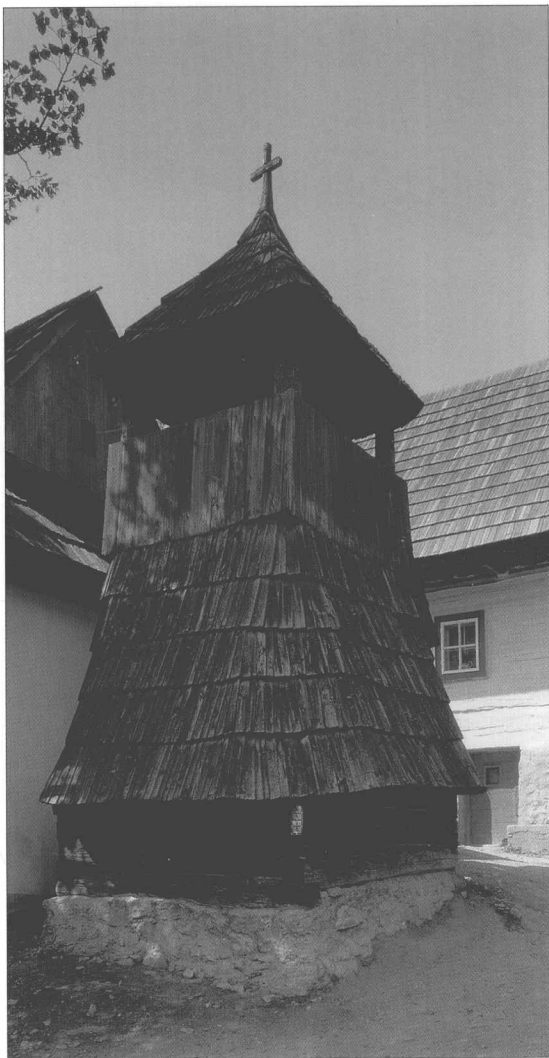
18世纪后半叶修建的钟楼也由木材建成，矗立在石砌的基座上。
