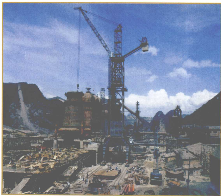
建设中的水城钢铁厂
