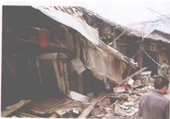
2006年7月22日，云南省昭通市盐津县5.1级地震之后，石门村土木房屋发生成片倾斜
