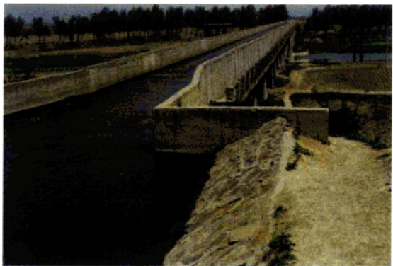
苏家屯区漕灌工程
