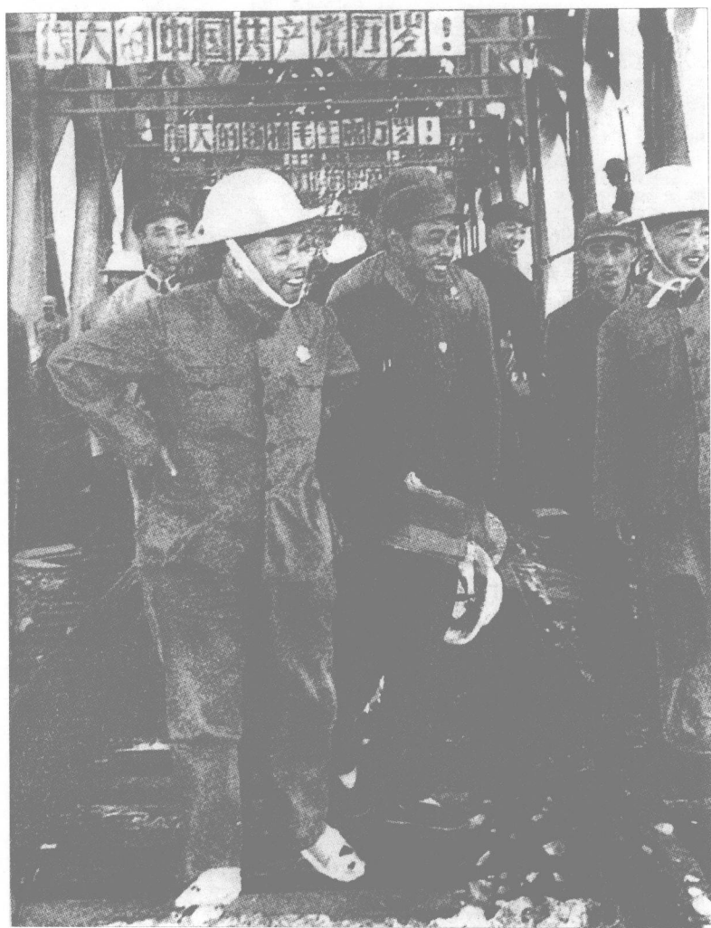
许世友视察南京长江大桥工地。
