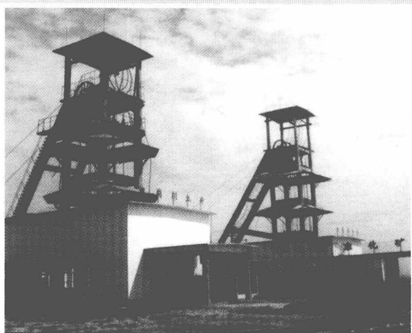
▲ 梅县矿务局槐岗煤矿矿主、副井。这是省属煤矿最晚建成的一对立井。
