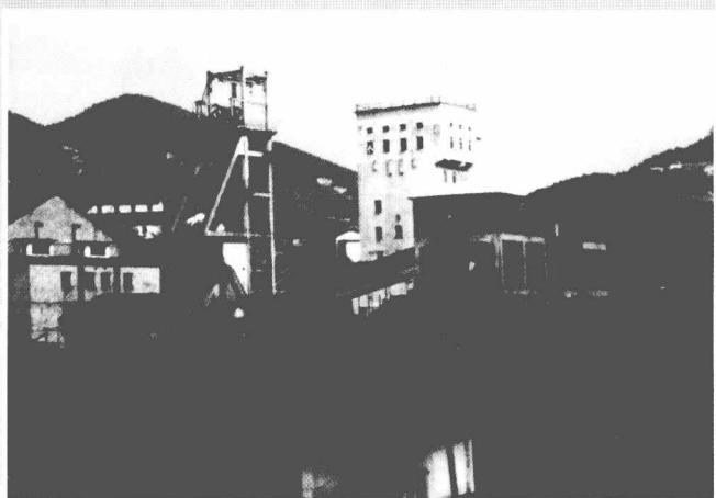
▲ 四望嶂矿务局四望嶂矿（一矿）立井，采用塔式摩擦轮提升机提升。
