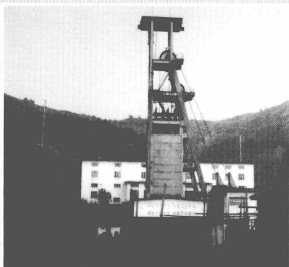
▲ 曲仁矿务局格顶矿（三矿）立井，采用落地式摩擦轮提升机提升。
