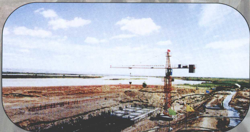
水源工程黄河泵站施工现场
