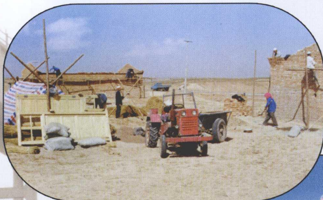
移民村建设中
