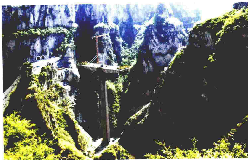
图19 晋焦高速仙神河独塔矮塔斜拉桥 (墩高达151.6m)
