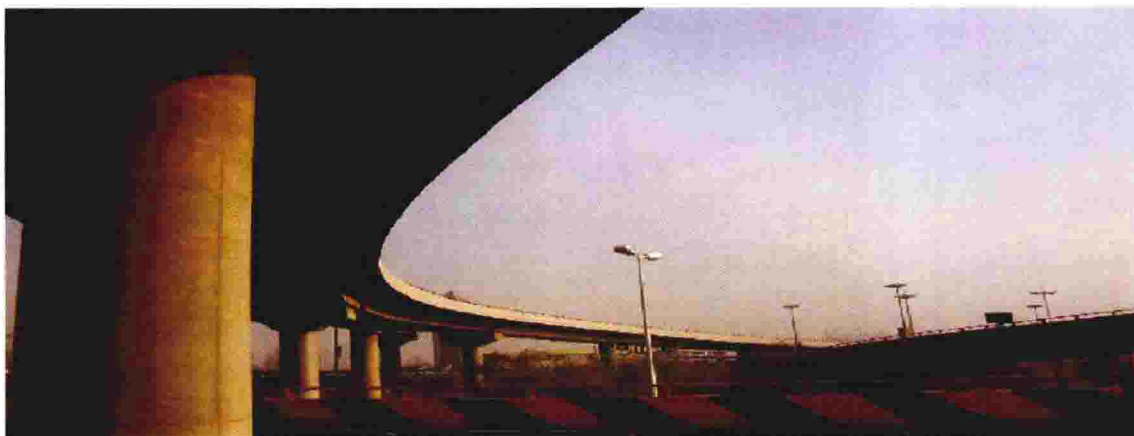
图12 太原武宿立交桥 (太旧高速, 1995年建成, 获鲁班奖)
