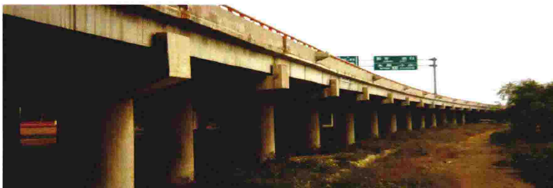
图13 太原绕城高速南段小店高架桥 (1999年建成, 又称十里长桥, 获鲁班奖)
