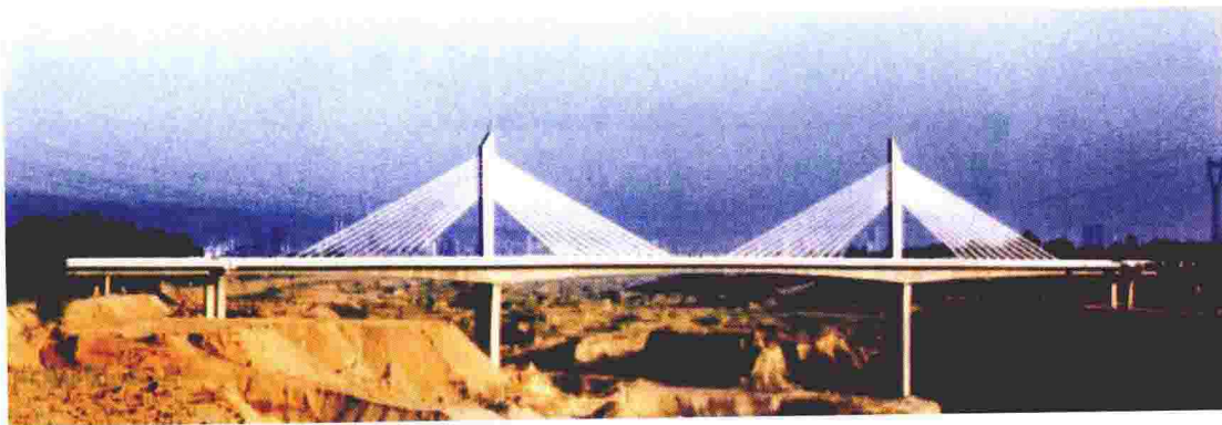
图18 汾河矮塔斜拉桥 (太原绕城高速西北段, 为85m+135m+85m三跨矮塔斜拉桥, 2004年建成通车)
