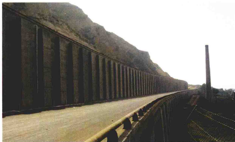
图11 汾离高速田家会分离式路基挡墙 (2005年建成通车)
