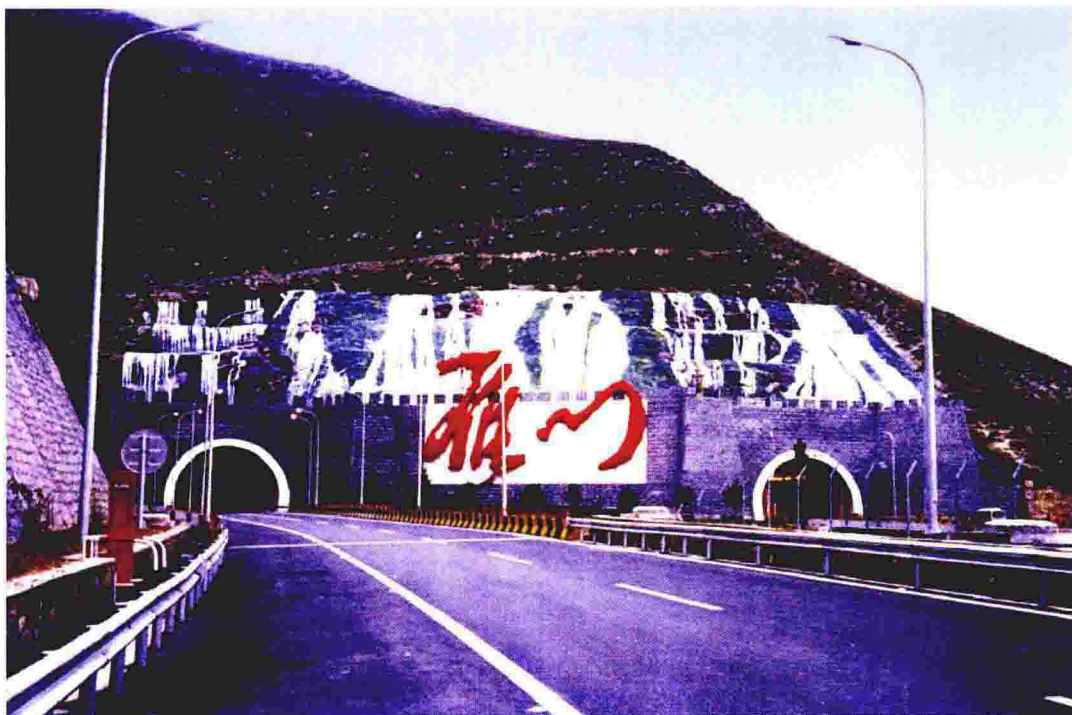
图21 雁门关隧道洞口位置图 (大运高速新原段, 2003年建成, 詹天佑奖、鲁班奖)
