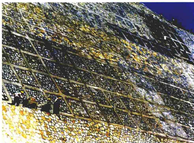
图9 大运高速石砌高边坡 (高达80余米)
