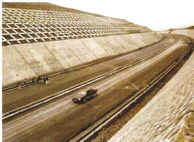
图10 长晋高速太义—换马滑坡处理 (2005年采用锚束框架+抗滑桩+抗滑墙及排水 设施综合处理)
