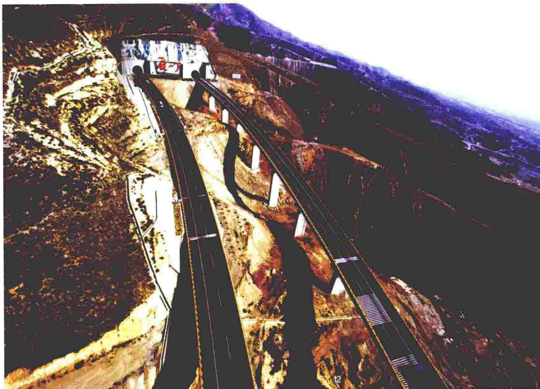
图4 大运高速雁门关隧道 (隧道总长10365m, 2003年建成通车, 获鲁班奖和詹天佑奖)
