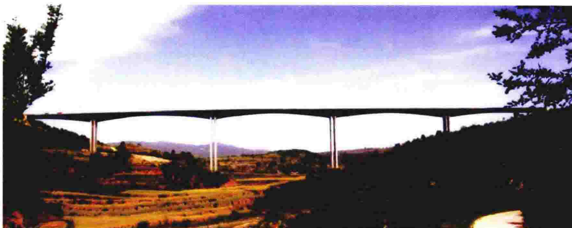
图14 晋济高速南河特大桥(桥高100m) (2007年建成, 为连续刚构, 桥长852m)
