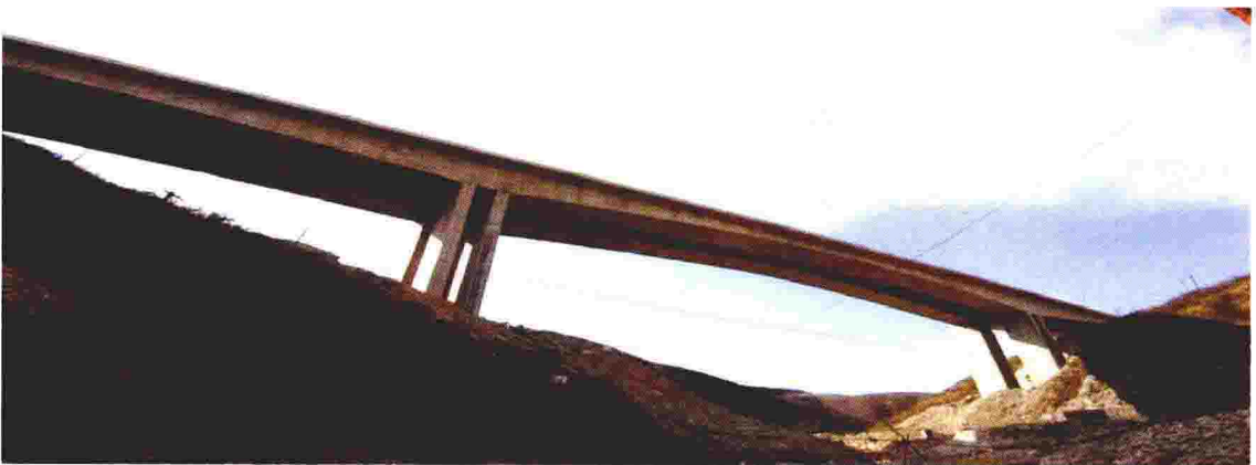
图17 阳城河2号桥 (汾离高速斜腿刚构, 2005年建成)
