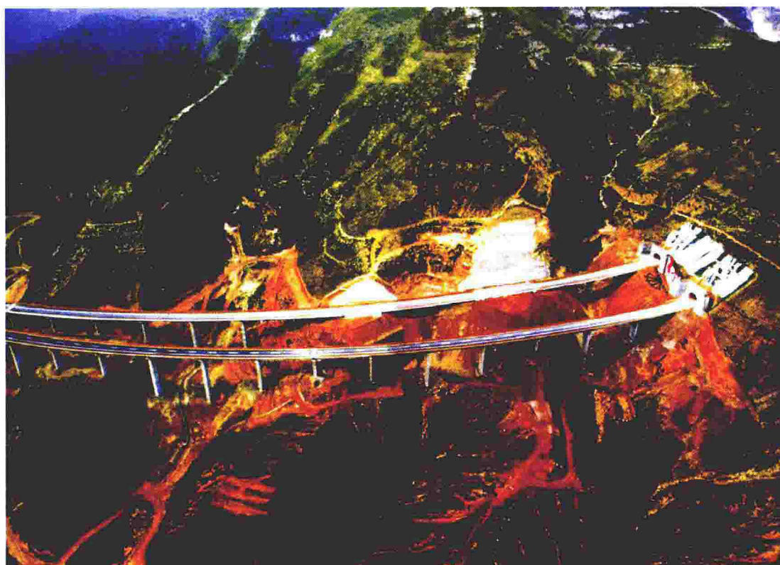
图6 大运高速公路韩信岭桥隧相连 (属祁临高速段, 长176.599km, 2002年建成, 获詹天佑奖)
