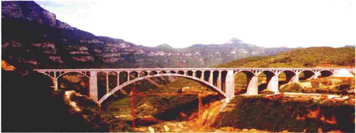
图15 晋焦高速丹河特大石拱桥 (2001年建成通车, 为146m世界最大跨径石拱桥)
