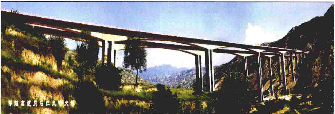
图16 仁义河大桥 (属祁临高速段, 2002年建成通车, 为刚构—连续组合梁桥, 全线工程获詹天佑奖)
