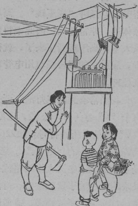
太高。于是人們想出个办法，把电压变高来輸送电流，这样电流損失小，到了接近用电地点，再把电压降低，供給大家使用。我們平常看到在两根电綫杆之間挂着的象黑箱子一样的东西，就叫“变压器”。能把低电压变成高电压的，叫“升压变压器”；能把高电压变成低电压的，叫“降压变压器”。
