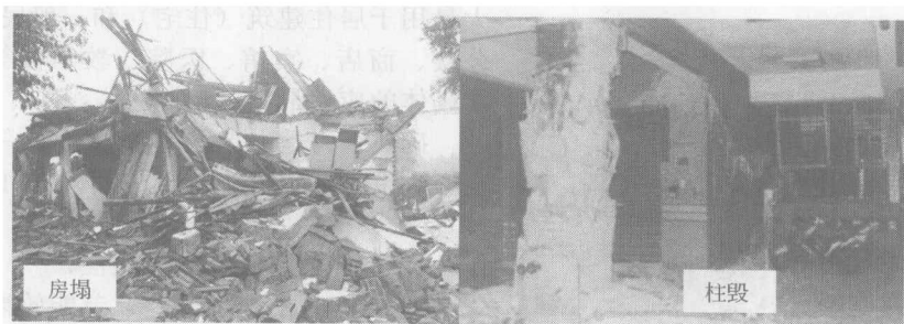
图 1-2 建筑结构承载力不足的教训
