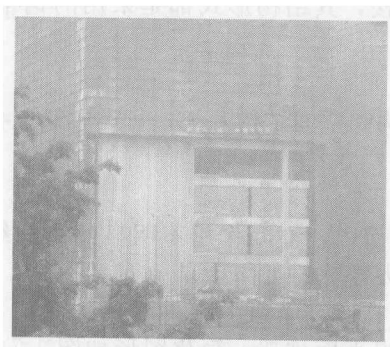
图 1-9 钢筋混凝土剪力墙结构房屋
