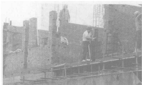
图 1-3 施工中的砖砌体结构
