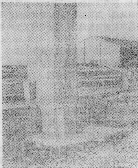
圖 5 用安裝楔子使立柱固定在基座上
