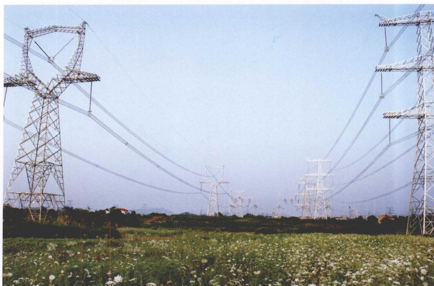
国家电网公司特高压交流试验线段几何尺寸可调，杆塔优化设计试验功能世界第一。 (国家电网公司 提供)
