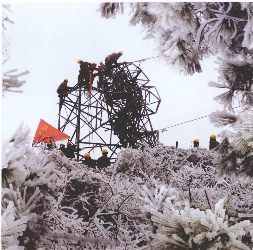
2008年1月29日，为确保贵阳春节供电，南方电网公司员工在筑观线抢险。
