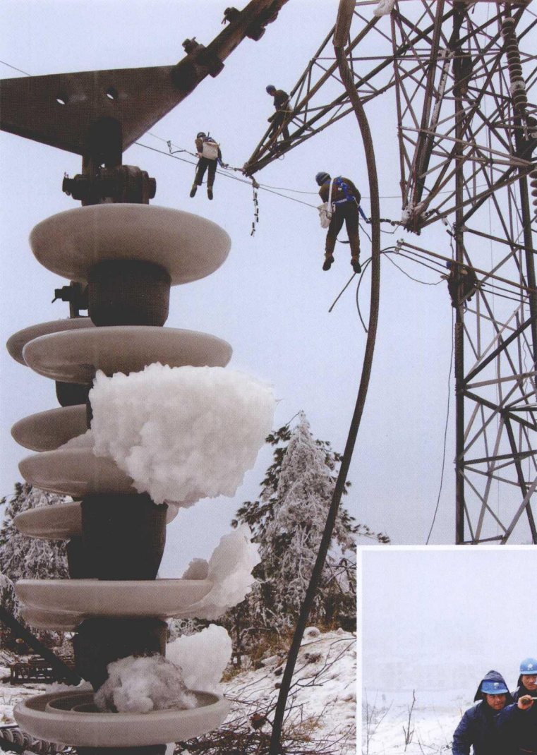
2008年2月3日，广州供电局抢险队在贵州220kV都凯线19号塔抢修。 (黄耀章 摄)
