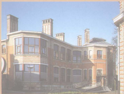
布鲁格曼医院，布鲁塞尔，比利时 Brugmann Hospital, Brussels, Belgium
