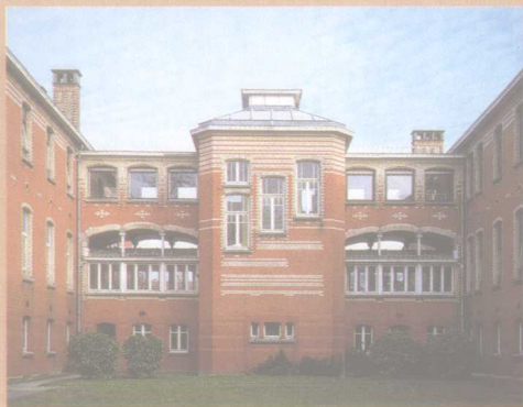
布鲁格曼医院，布鲁塞尔，比利时 Brugmann Hospital, Brussels, Belgium
